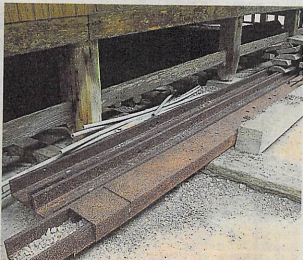
寺の境内に放置されている鉄骨。発射台のレールに使用される予定だった＝南房総市下滝田の「知恩院」
