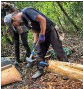
▲ 丸太の下部を焼いて炭化した柱を埋めると土中の水流が滞らない
