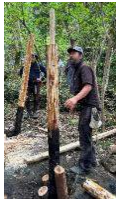
▲ 丸太の下部を焼いて炭化した柱を埋めると土中の水流が滞らない
