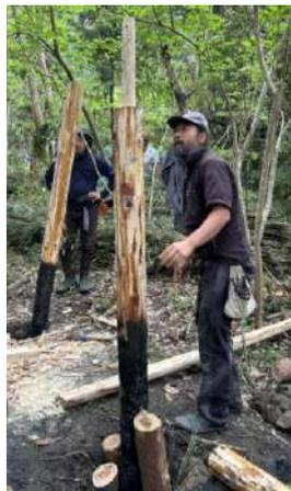
▲ 丸太の下部を焼いて炭化した柱を埋めると土中の水流が滞らない
