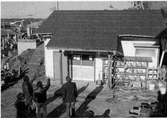
補修が完了した建物を視察する関係者＝館山
