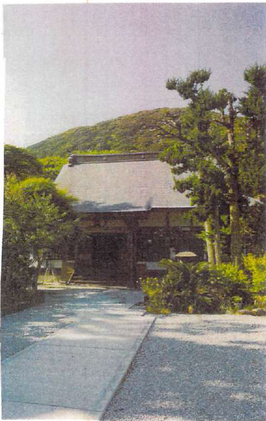
圓光寺本堂。建物は平成に入ってから再建されて、往時の面影はないが、「本堂脇の建物の中2階に青木とたねが滞在したと伝えられています。当時は住職不在だったのかもしれない」と現住職の池田英乘さん。
